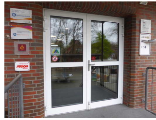
Eingangstür nach Treppe
