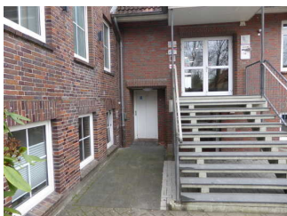
Aufzug und Treppe
